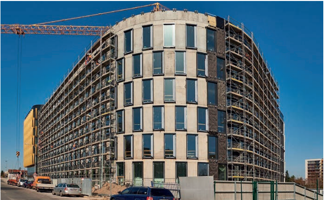
Pohled na rozpracovanou fasádu administrativní budovy A z Kladenské ulice
