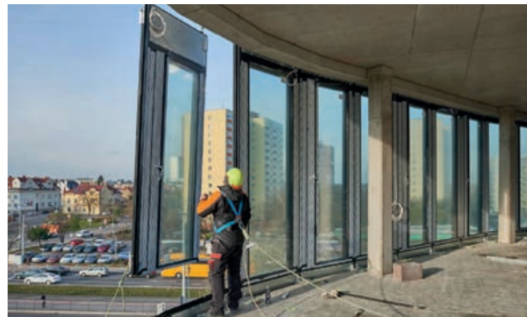
Probíhající montáž modulové fasády na objektu B ve 4. patře
