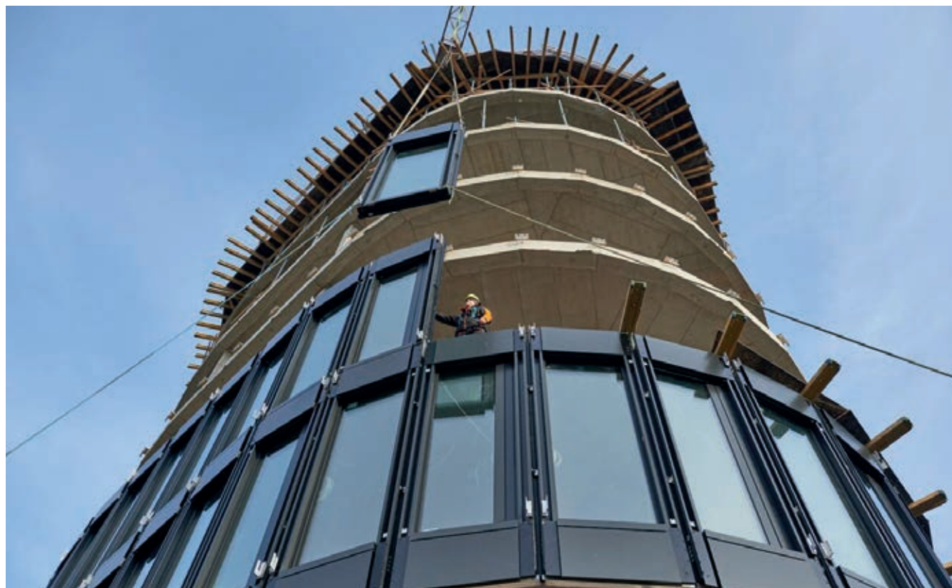
Montáž modulové fasády na objektu B
